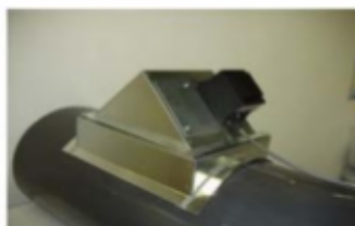
Montagedetalj för rundkanal med kanalpåslag
